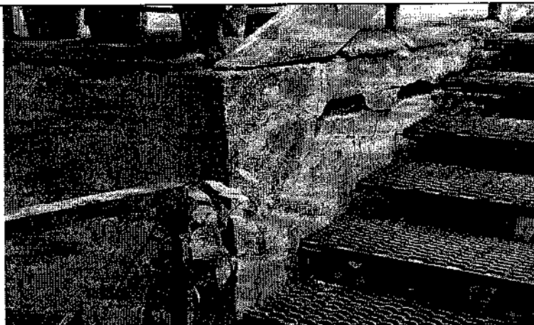
Фото 2. Крыльцо здания. Выбоины, разрушение, многочисленные трещины штукатурного покрытия крыльца здания, что не соответствует требованиям раздела 4 СП 71.13330.2011 «Изоляционные и отделочные покрытия. Актуализированная редакция СНиП 3.04.01-87 (с Изменением N 1)».
